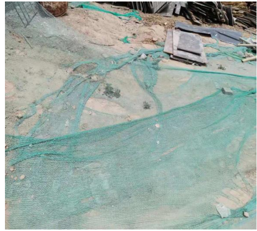
主体工程区苫盖
