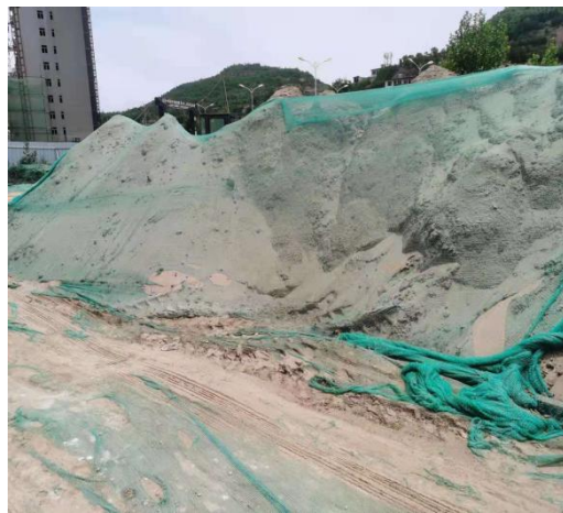
临时堆土苫盖
