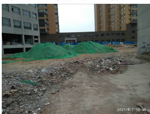
防护网临时苫盖
