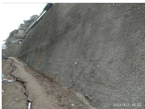
场地东北侧原有边坡采用喷浆防护
