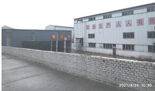
工业场地封闭式洗选车间及煤泥库
