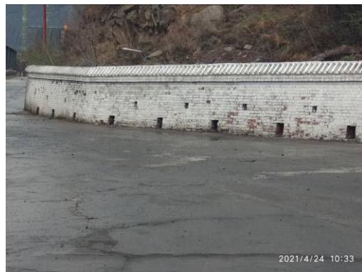
工业场地边坡坡脚挡墙
