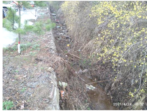
工业场地南侧排洪渠
