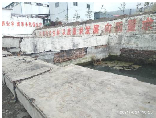
工业场地雨水收集池
