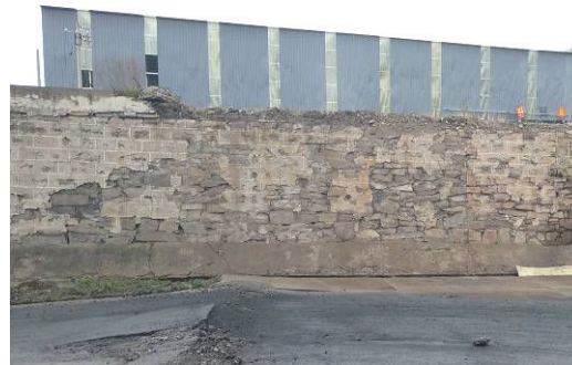
工业场地封闭式矸石库及台阶边坡挡墙
