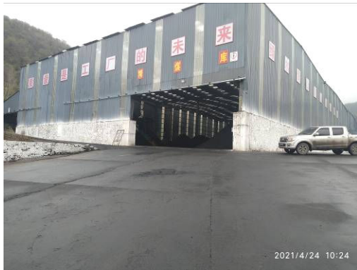
工业场地封闭式精煤库
