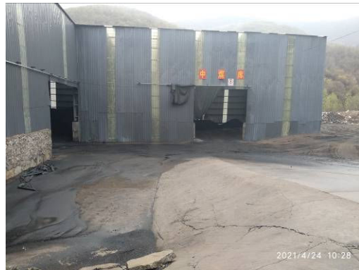
工业场地封闭式中煤库
