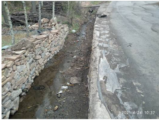
工业场地南侧排洪渠
