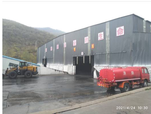
工业场地封闭式原煤库
