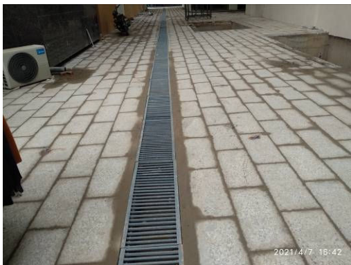
商业楼间地面排水沟
