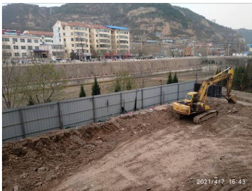
6#商业楼临河侧地面
