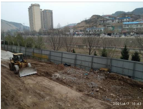
6#商业楼临河侧地面
