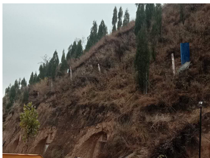
工业场地北侧边坡
