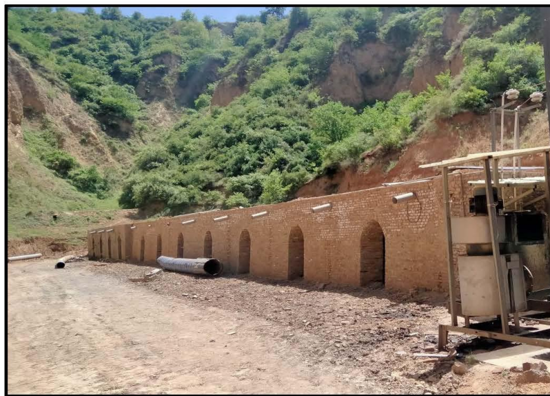
厂区现有工程炭化窑
